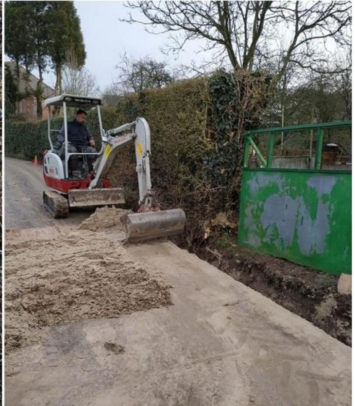
Extension du réseau d'eau potable Impasse du crocq renoit .Tranchée réalisée par les employés communaux et pose de la canalisation par le SIDEALF
