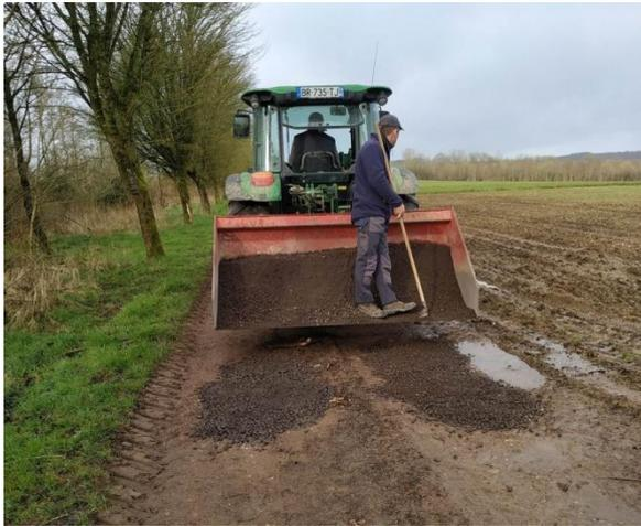
Mise en place de 80 tonnes de laitier 0/30 par les employés communaux sur le chemin du bois Lamotte à la Raiderie et réfection du chemin de la chapelle du mont
